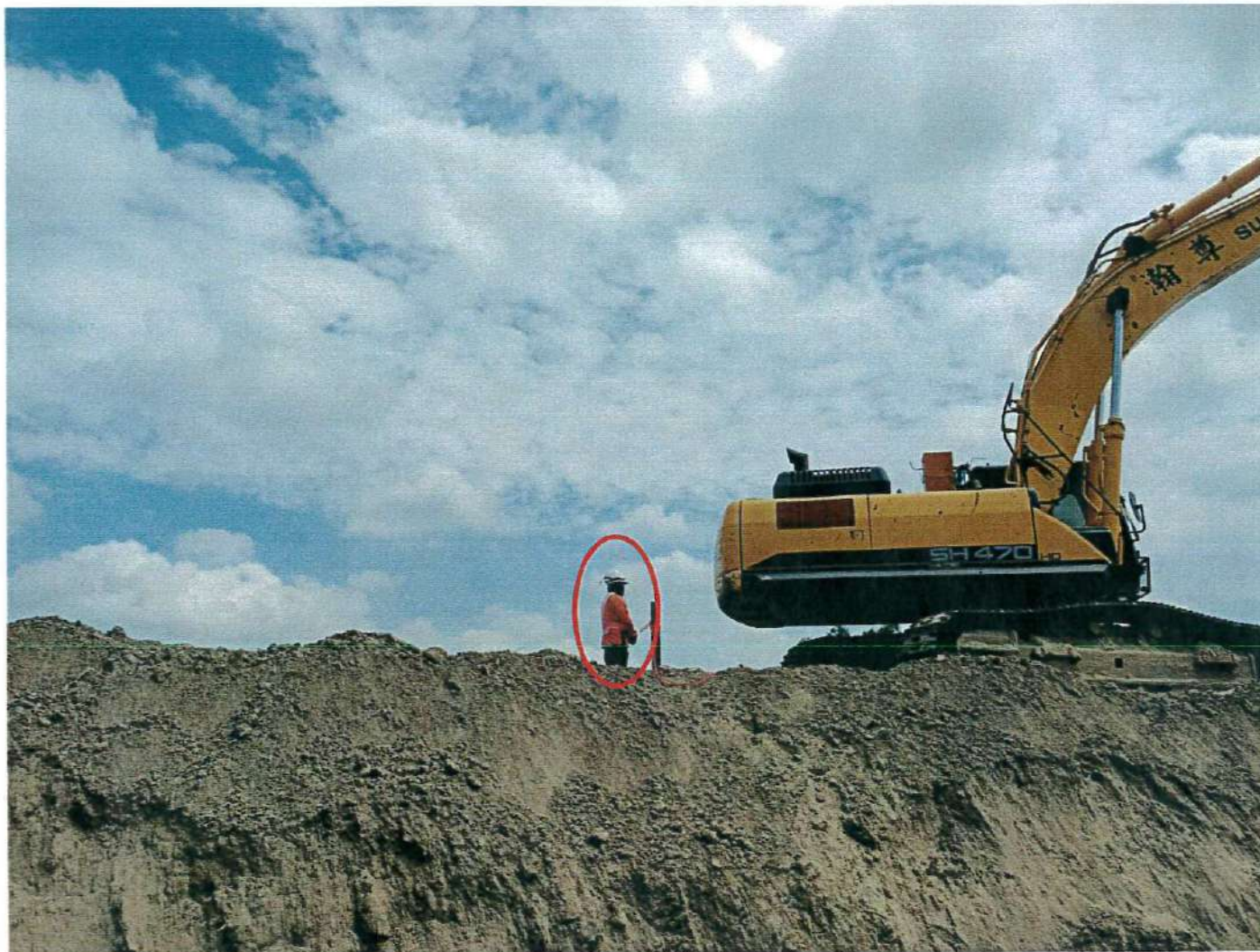
圖 3、指派專員監視挖土機施工相片
