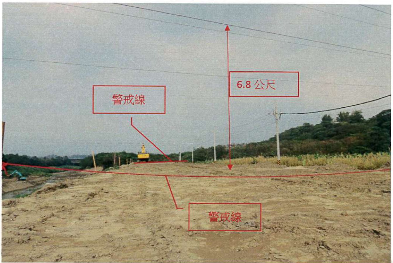
圖 2、警戒線設置(2線間為配合停電施工範圍)相片
