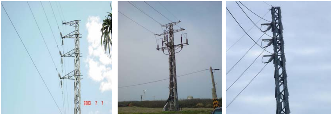
圖 2.6 鐵柱型支持物外觀(大部份用於 69 仟伏)
