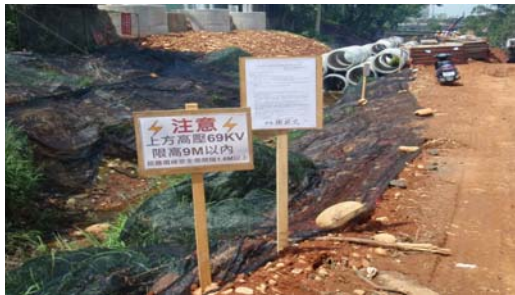
(圖 3) 工地豎立警示牌
