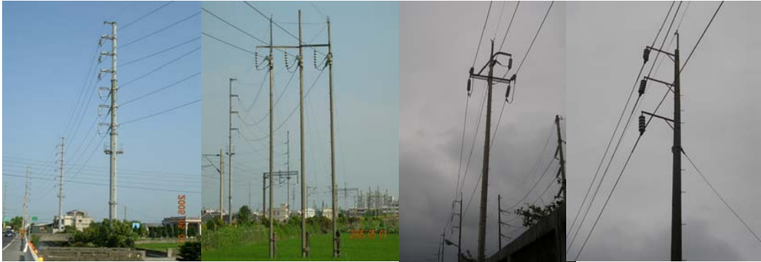
圖 2.5 電桿型支持物外觀(大部份用於 69 仟伏)
